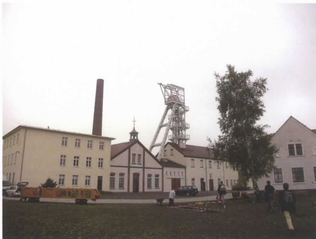
フライベルク鉱山の施設は、現在も大学の実習坑道として整備活用されている。(一般の見学も可。)
