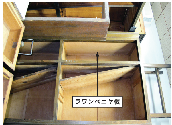
図26 部分修理された天板の内部 (ラワンベニヤ板で部分修理)
